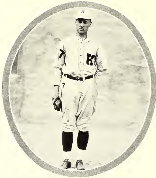
H. GILMAN Utility
